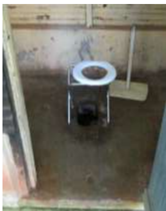
【写真】 トイレ内部
