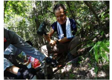
急斜面での作業
