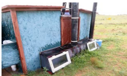
トイレの後ろ側
